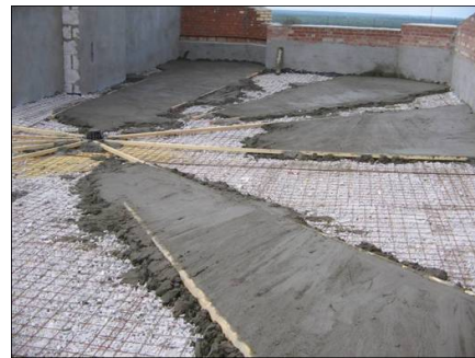
Для обеспечения требуемого сопротивления теплопередаче совмещенного покрытия достаточно слоя крошки толщиной 0,5 м
