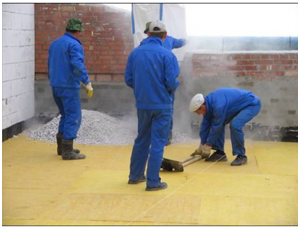
Первоначальное разравнивание - стандартным ручным инструментом
