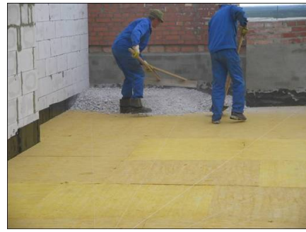
Первоначальное разравнивание - стандартным ручным инструментом
