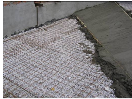
Армированная растворная стяжка под гидроизоляционный ковер укладывается поверх крошки обычным способом, без устройства разделительных мембран
