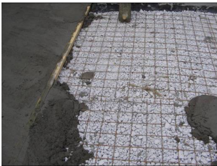
Для обеспечения требуемого сопротивления теплопередаче совмещенного покрытия достаточно слоя крошки толщиной 0,5 м
