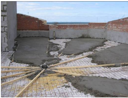
Армированная растворная стяжка под гидроизоляционный ковер укладывается поверх крошки обычным способом, без устройства разделительных мембран
