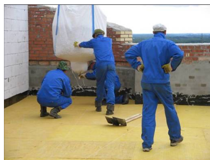
Разгрузка производится через нижний клапан
