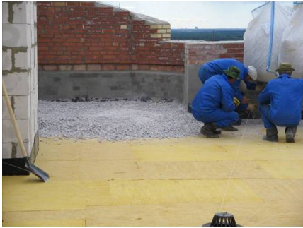
Разровненная крошка образует устойчивую не осыпающуюся поверхность, стойкую к пешеходным нагрузкам
